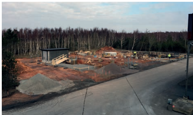
Markarbeten i Höganäs, februari 2018.
