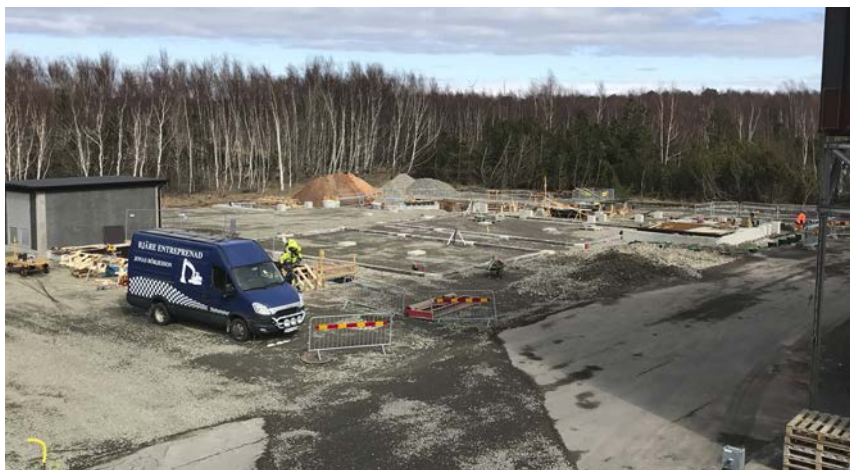
Pågående markarbete i Höganäs.
