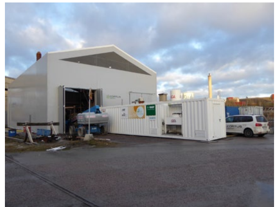
Bygget i Köping december 2014 där container för metanisering kommit på plats utanför
