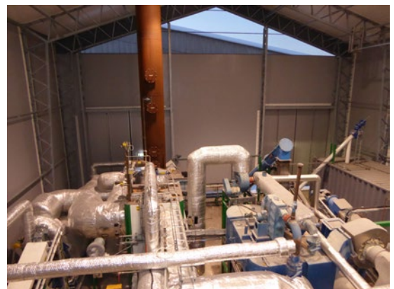
Installation av WoodRoll®-processen i Köping, 2015.
